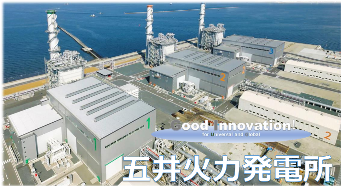
世界最高水準の高効率発電設備を備えた最新鋭のコンバインドサイクル発電所
